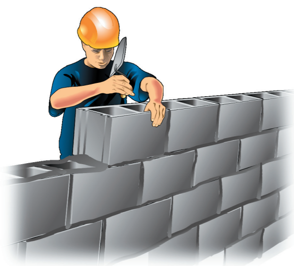
Posa a giunti verticali sfalsati
