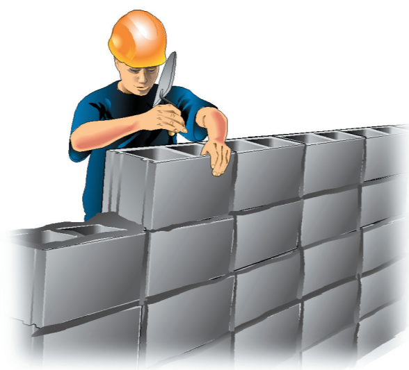
Posa a giunti verticali allineati (a sorella)
